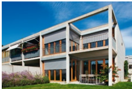
KNX für mehr Energieeffizienz
